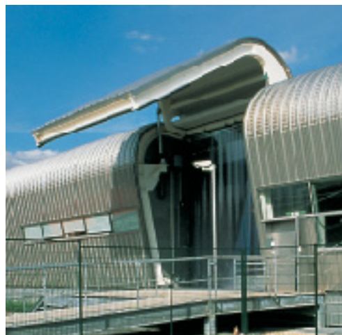
La grande porte d'entrée s'ouvre à l'aide de deux vérins hydrauliques.
